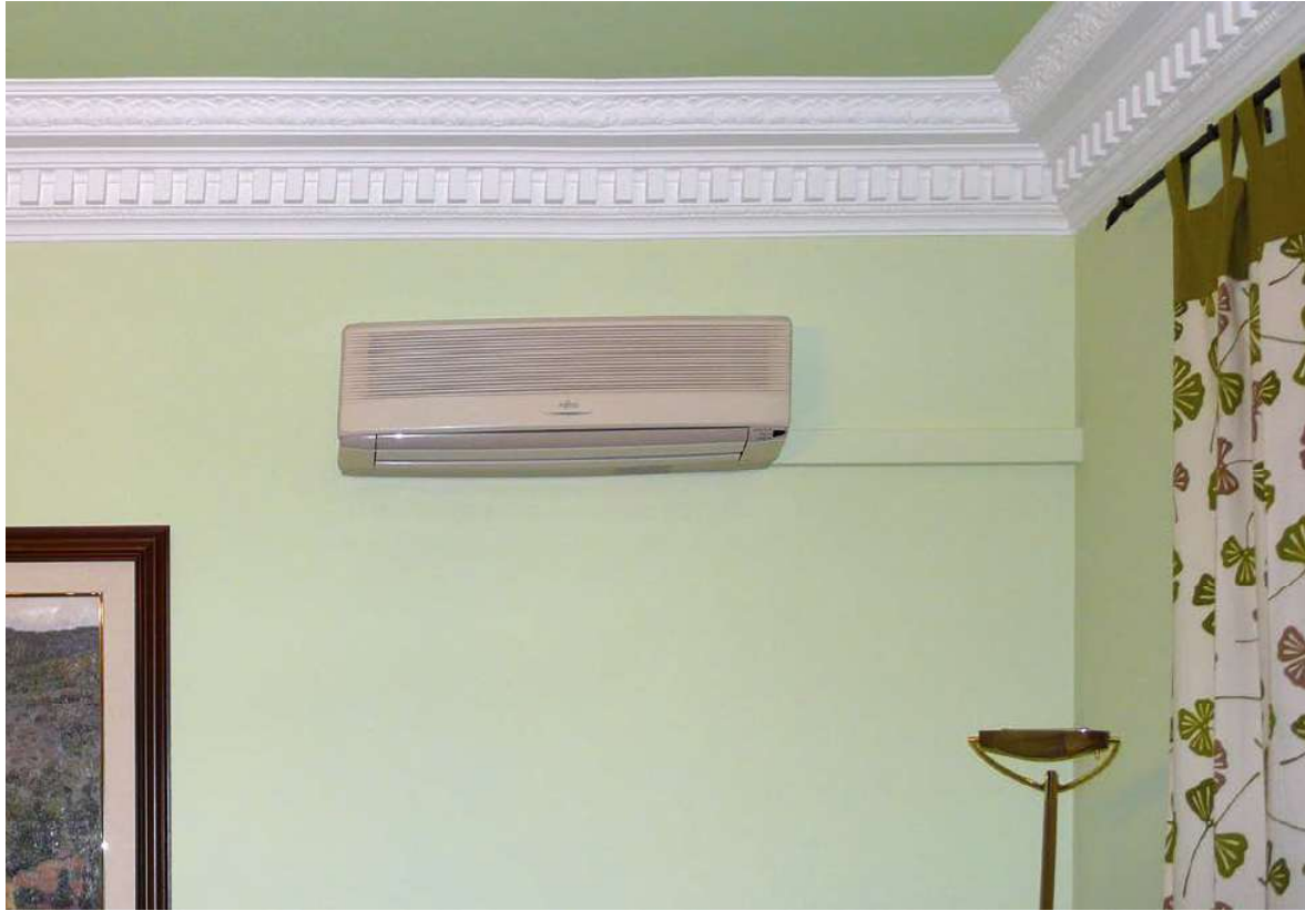
Rehabilitación de viviendas
