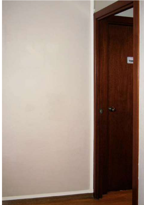
Rehabilitación de viviendas
