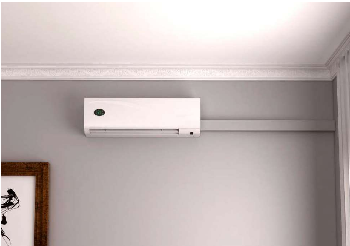
Rehabilitación de viviendas
