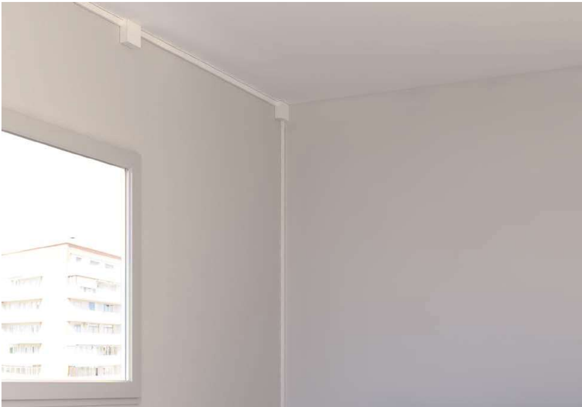
Rehabilitación de viviendas
