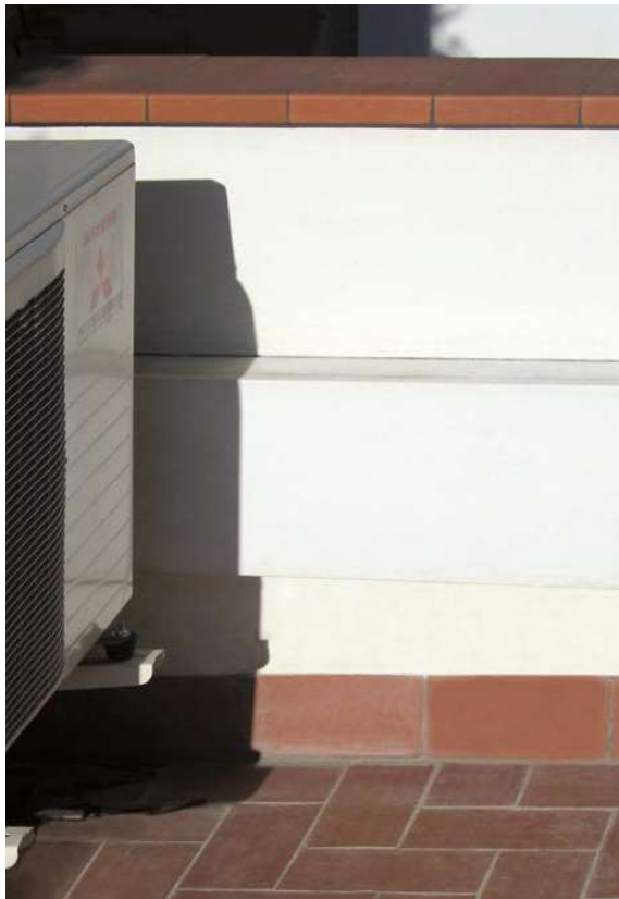
Rehabilitación de viviendas
