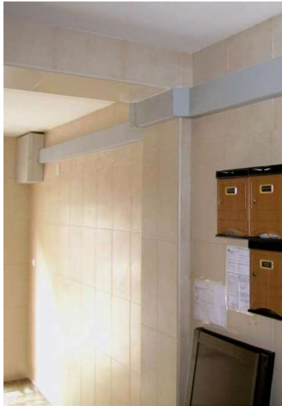
Rehabilitación de viviendas
