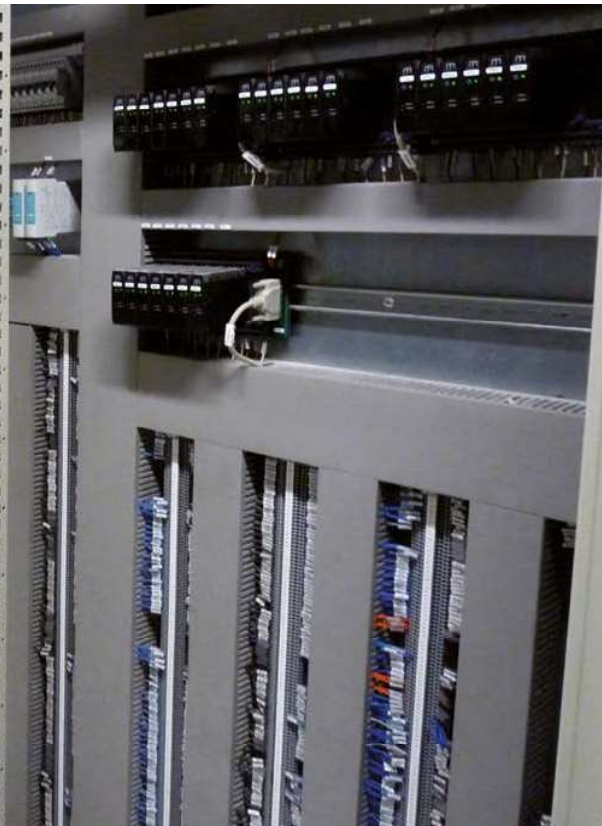
Tratamiento de aguas
