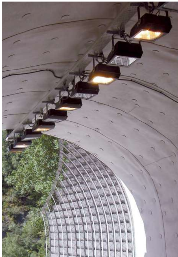
Infraestructura viaria: túnel
