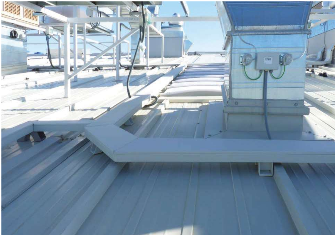
Energía fotovoltaica: depósito de autobuses
