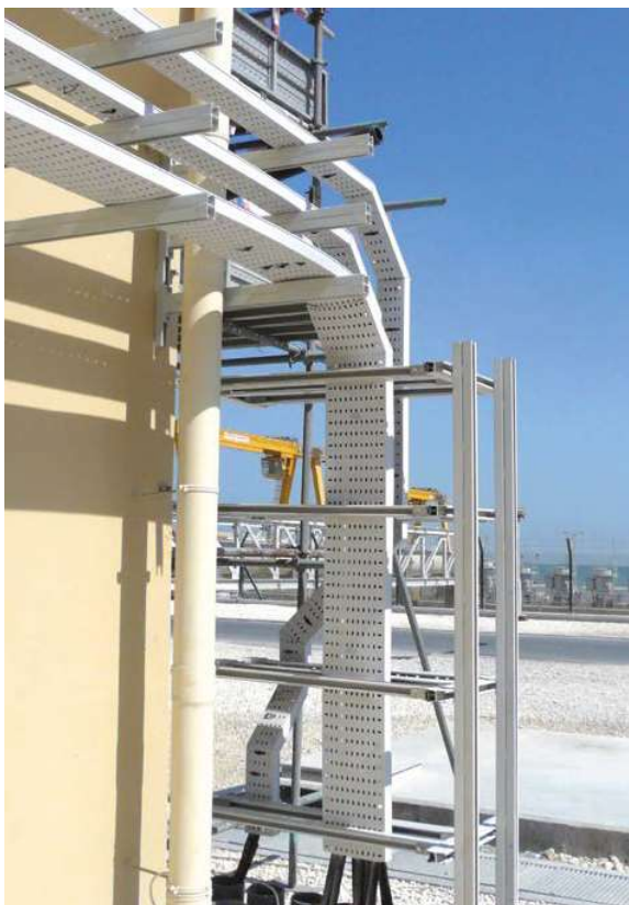
Tratamiento de aguas: desalinizadora
