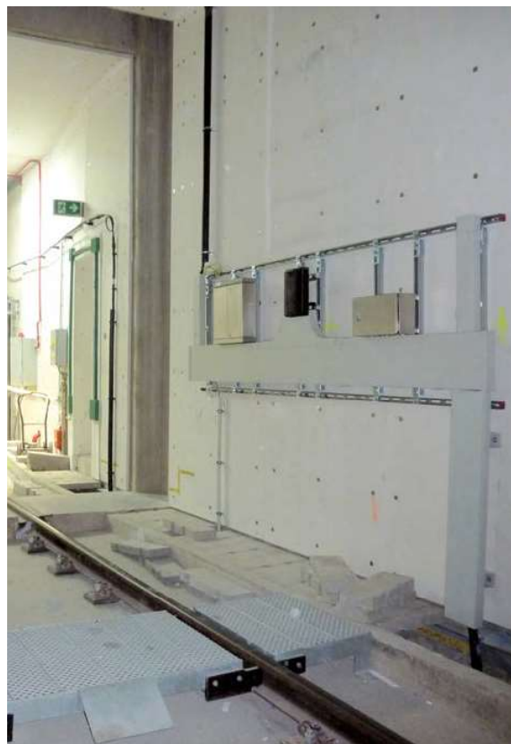
Infraestructura ferroviaria: túnel
