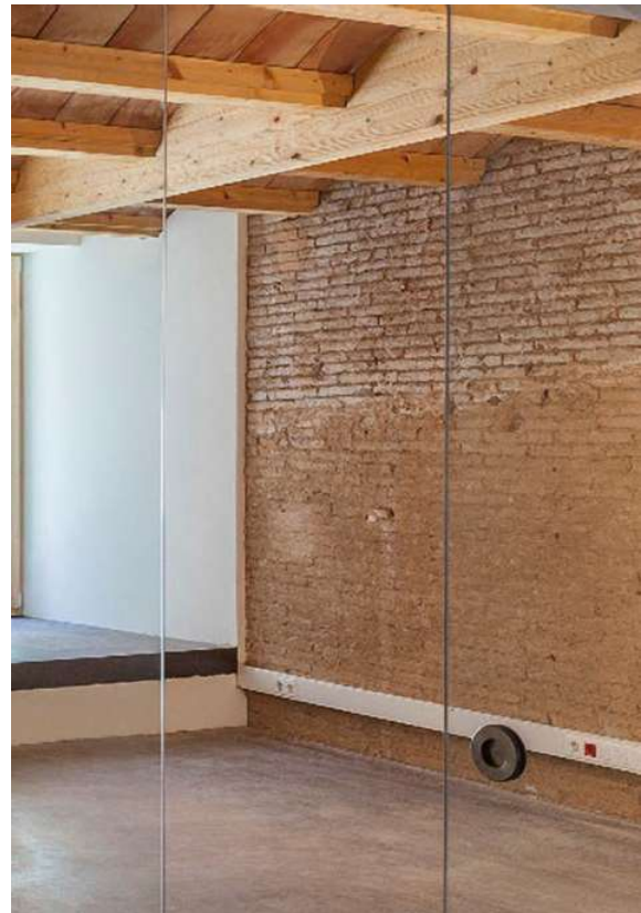
Espacios de trabajo: rehabilitación de oficina
